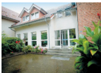
JVA-Außenstelle: Am Pavenstädter Weg 233 sind 76 Haftplätze eingerichtet. FOTO: MARTINSCHLEDDER
