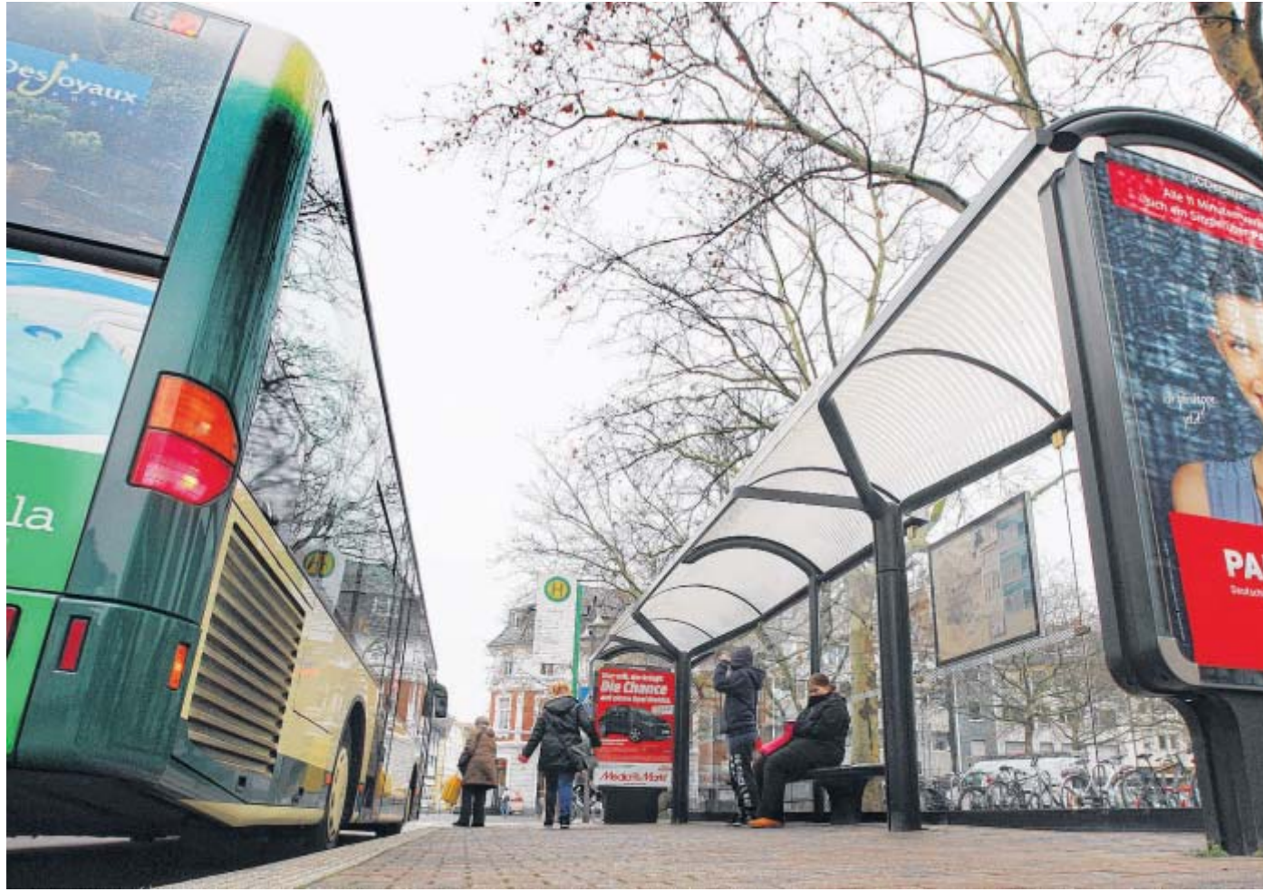
Wird demontiert: Die alten Buswartehallen verschwinden ab Januar. Das gilt auch für diese am Rathausvorplatz. Bis September errichtet die Stadt neue Unterstände. FOTO: PATRICK MENZEL
