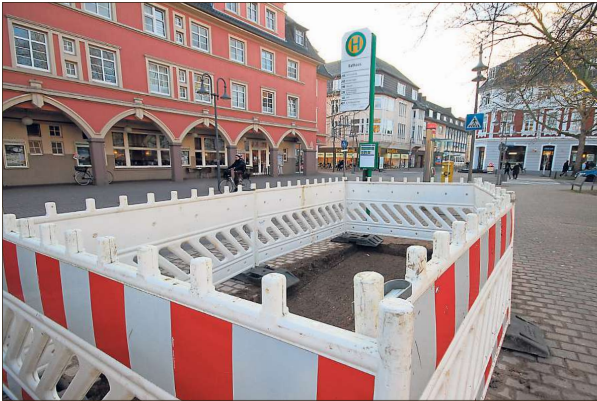
Abgesperrt: Die Standorte, an denen in den nächsten Wochen an den Haltestellen hölzerne Unterstände als Übergangslösung aufgestellt werden sollen (hier Strengerstraße), sind abgesperrt. Bilder: Dinkels (2)
