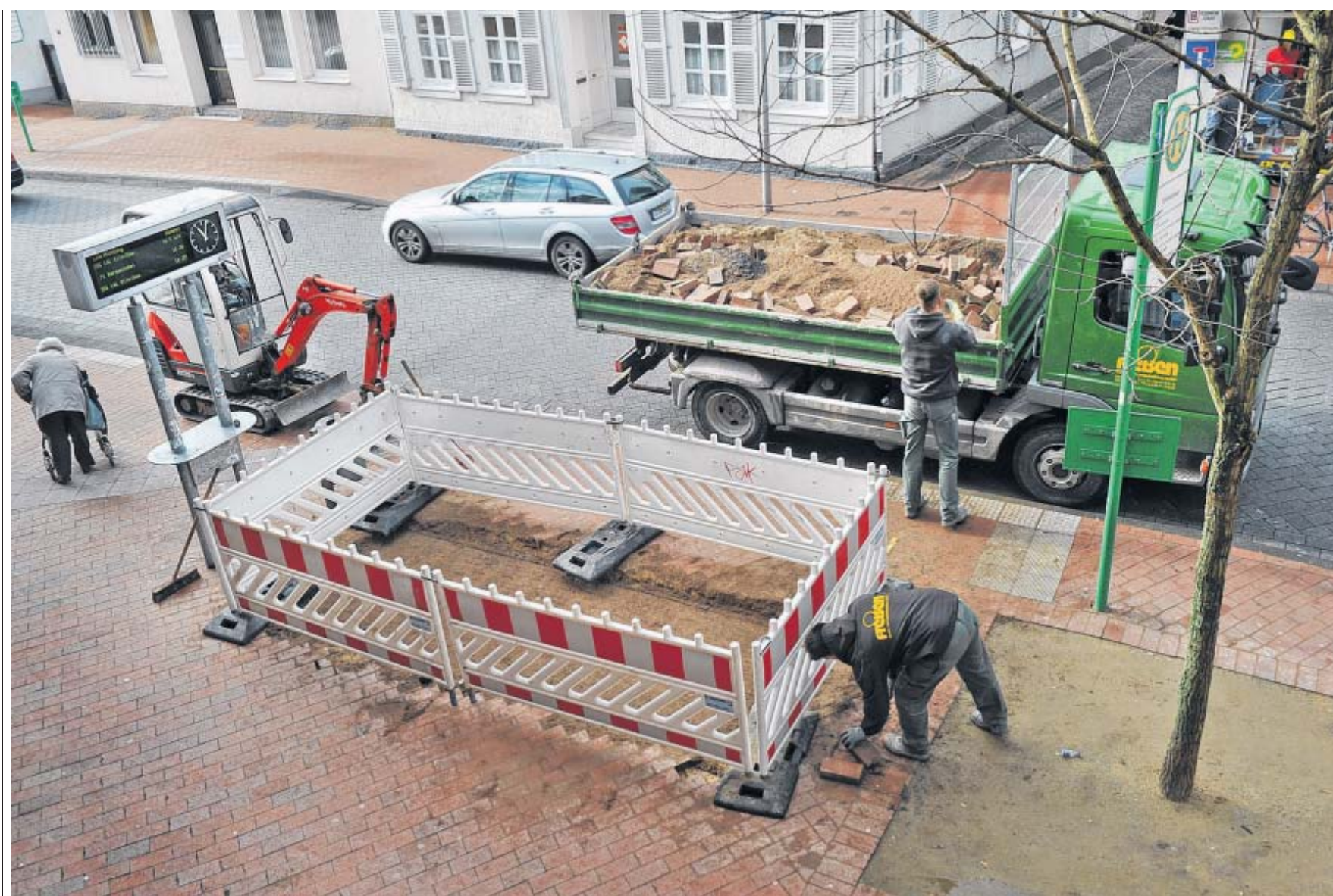
Boden bereitet: Die Haltestelle Spiekergasse an der Münsterstraße zählt zu den Ausnahmefällen, in denen in dieser oder der nächsten Woche provisorische Wartehäuschen errichtet werden. Garten- und Landschaftsbauer präparierten den Untergrund für die Aufnahme der Bodenplatte. FOTOS: RAIMUND VORNÄUMEN
