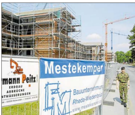
Heimische Firmen haben in den vergangenen Jahren von Aufträgen für Neubauten und Sanierungen in den beiden Gütersloher Kasernen, hier die Princess Royal Barracks, profitiert. Bilder (2): Dinkels
