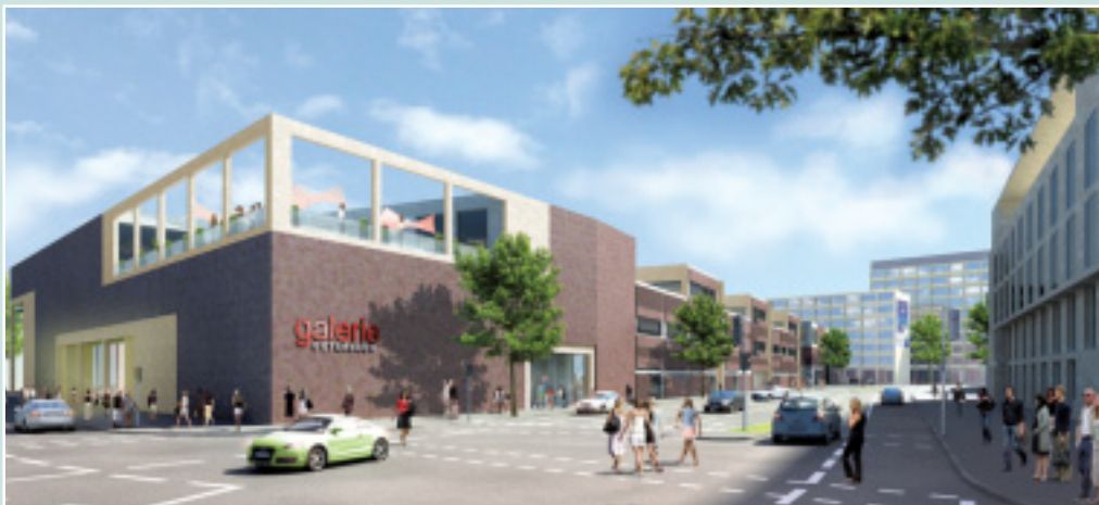
Blick auf die galerie GÜTERSLOH von der Friedrich-Ebert-Strasse / Ecke Kaiserstrasse. Die kleinteilige Gliederung der Fassade unterstreicht den städtischen Charakter des Areals.
