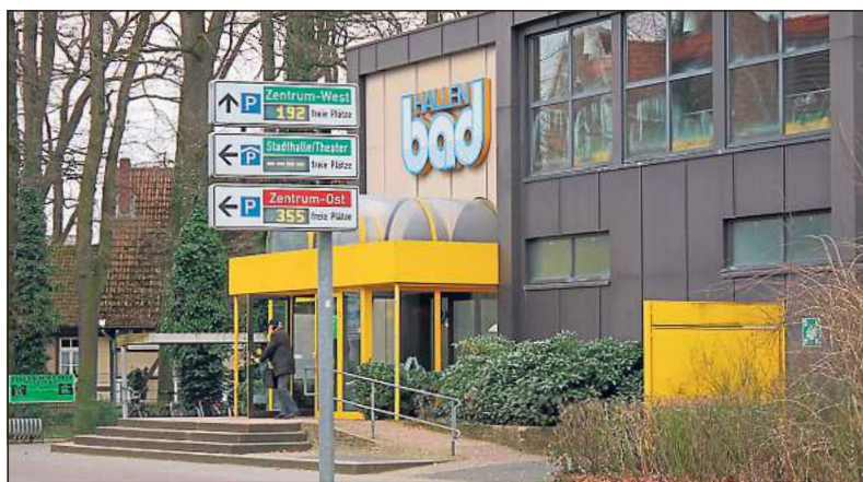
Soll im Herbst geschlossen und dann abgerissen werden: das Hallenbad an der Herzebrocker Straße. Bild: Reckordt
